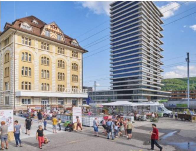
Die Bauarbeiten auf dem Areal der Zentrale haben begonnen.
