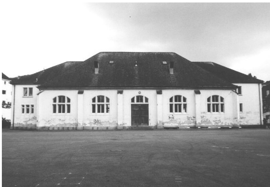
Ansicht Nord, vor der Sanierung
