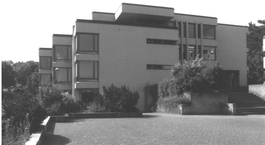
Schule, Fassade Nordost
