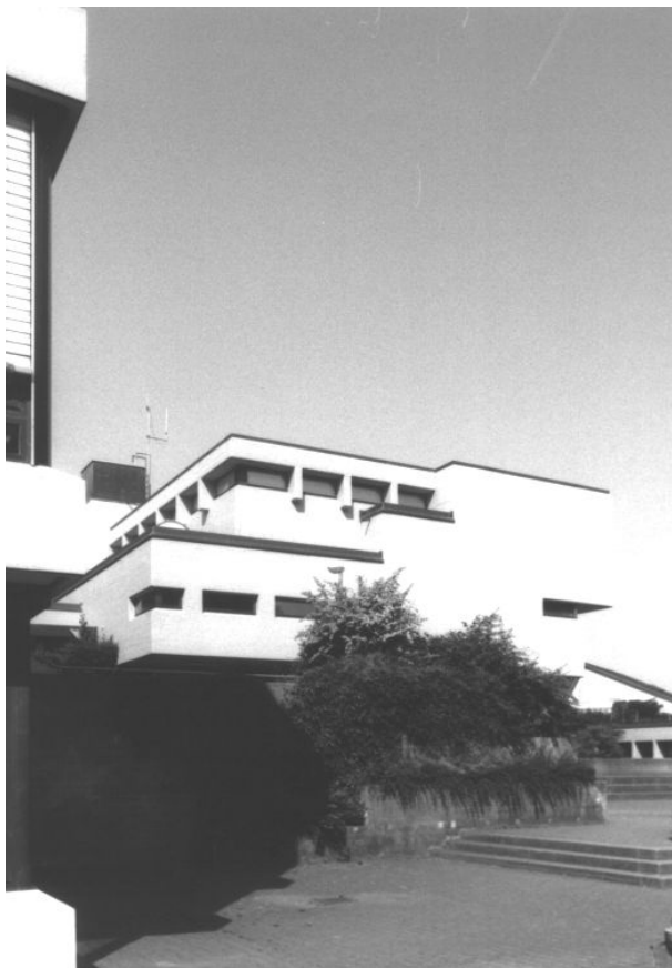
Aula, Fassade Nordost
