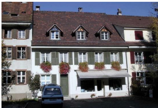
Beispiel einer erhaltenswerten Baute
